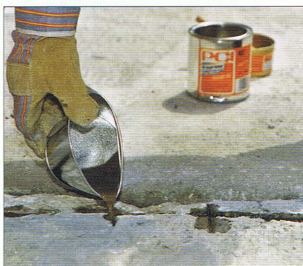
Kraftschlüssiges Verschließen von Rissen durch Vergießen mit PCI-Apogel® F
