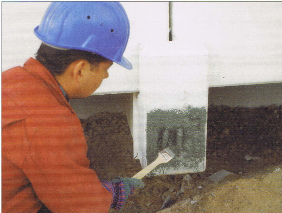
Der mineralische Korrosionsschutz nach ZTV-SIB 90 PCI-Legaran® RP bildet einen dauerhaften Schutz gegen die korrosionsfördernde Wirkung von Tausalz und karbonatisiertem Beton
